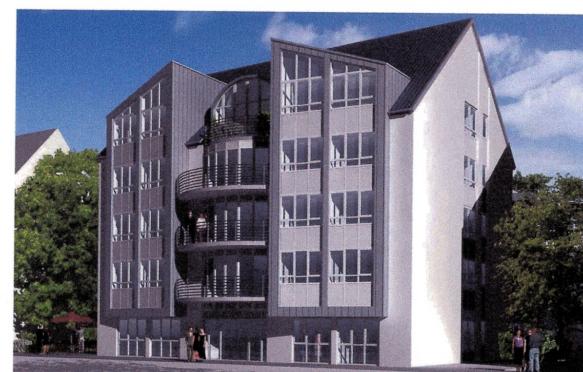
vordere Ansicht Alte Schulstraße aus Richtung Nordwesten
